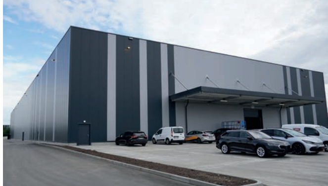
Der neue, hochmoderne Schnellecke-Standort in Kabelsketal: Hier geht Logistik mit innovativer Technologie Hand in Hand.
